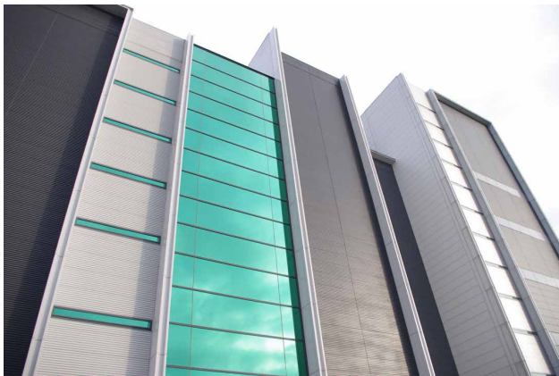
2009年に稼働したアイネットのCloud Data Center「inet primary®」
